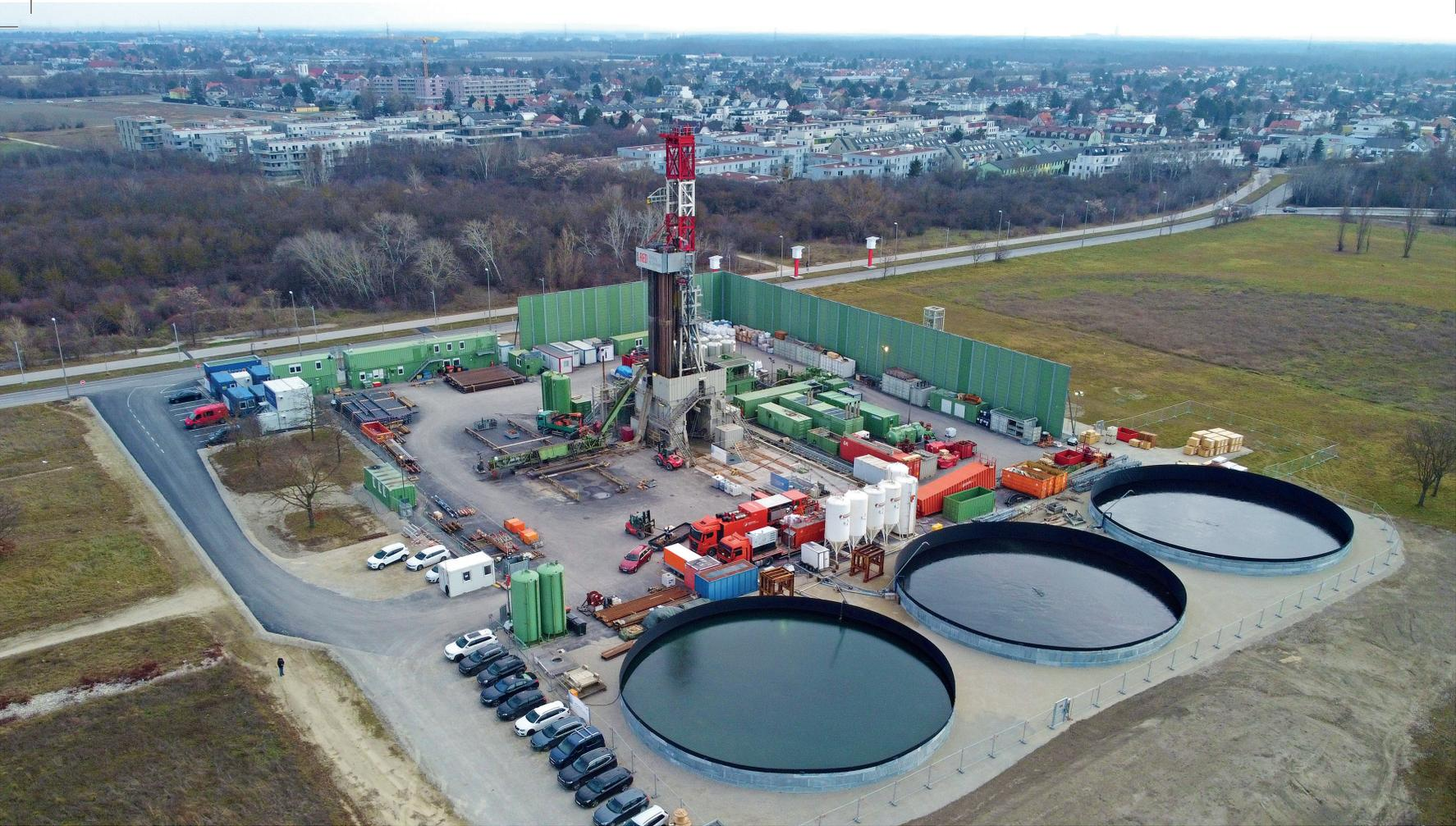
OMV und Wien Energie bohren im Joint Venture „deep“ rund 3.000 m in die Tiefe, um das natürliche Heißwasservorkommen im „Aderklaaer Konglomerat“ zu nutzen. Durchgeführt wird die Bohrung durch die RED Drilling & Services GmbH. Zum Einsatz kommt eine Bohranlage Bentec Euro RIG 250.
